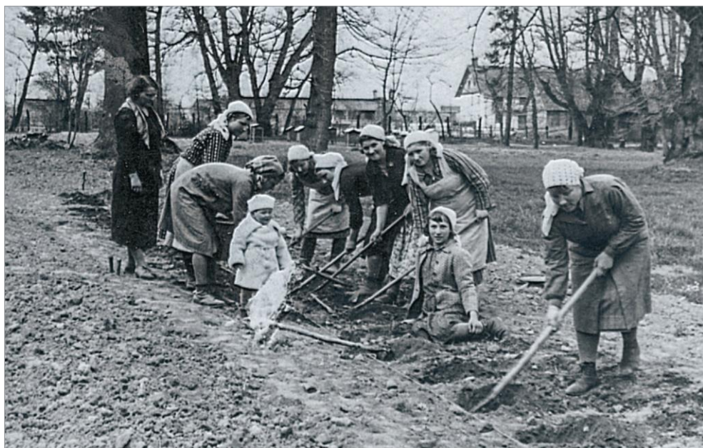
Ryc. 9. Uczennice Ludowej Szkoły Rolniczej Żeńskiej w Sitnie podczas sadzenia róż w parku. W tle budynek inwentarski popołowarczny oraz wybudowane w latach międzywojennych na potrzeby szkoły: kurnik i stodoła, lata 20.–30. XX w. Fot. autor N.N. [zbiory LODR w Końskowoli PODR w Zamościu z siedzibą w Sitnie].
