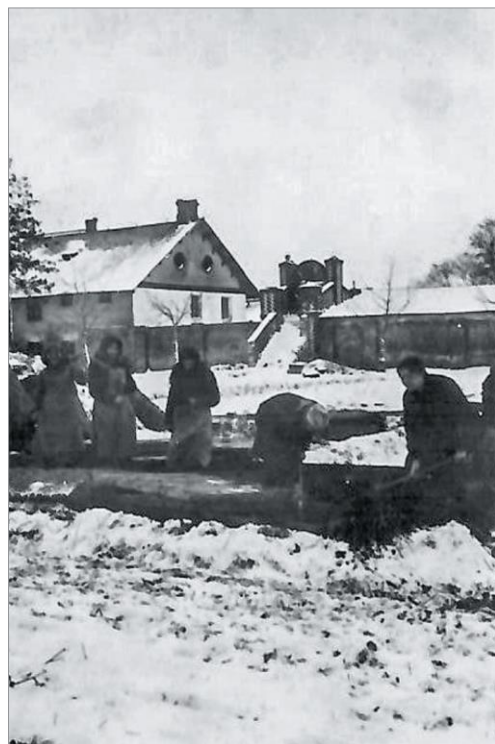
Ryc. 10. Widok na budynek inwentarski od strony północnej (z ogrodu), wysoki płot otaczający ogród od południa, reprezentacyjną bramę wejściową do ogrodu (XIX w.?) oraz kurnik (po lewej), zbudowany na potrzeby Ludowej Szkoły Rolniczej Żeńskiej w Sitnie w 1929 r. Na pierwszym planie uczennice Szkoły Ludowej podczas prac w ogrodzie, 25 marca 1937 r.
