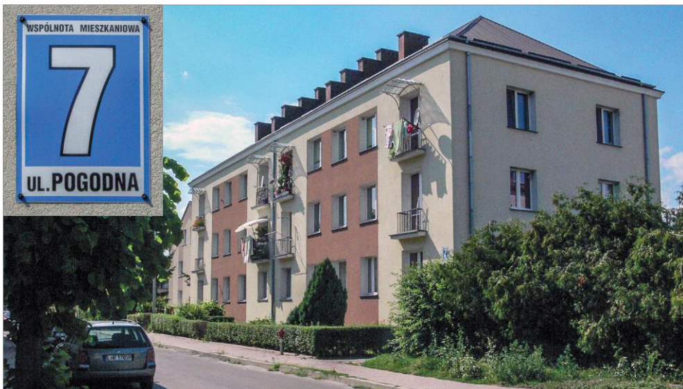
Ryc. 13. Budynek przy ul. Pogodnej nr 7, którego budowę nadzorował śp. Stanisław Krasnopolski (położony niemal w połowie odległości pomiędzy ratuszem a wspomnianą kamienicą), którego fundamenty zapadły się następnego dnia po zalaniu. Fot. J. Panasiewicz, 2 lipca 2016 r.
