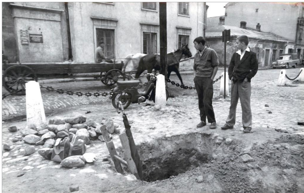
Ryc. 9. Prace remontowo-konserwatorskie na Starym Mieście w Zamościu. Zamość, ok. 1970 r. Autor N.N. [APZ, Spuścizna Macieja Pawlickiego emerytowanego profesora Politechniki Krakowskiej, ser. 1, sygn. 49].
