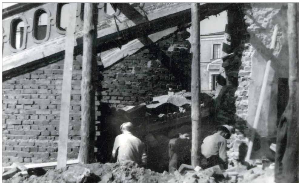
Ryc. 8. Prace remontowo-konserwatorskie na Starym Mieście w Zamościu. Zamość, ok. 1970 r. Autor N.N. [APZ, Spuścizna Macieja Pawlickiego emerytowanego profesora Politechniki Krakowskiej, ser. 1, sygn. 49].
